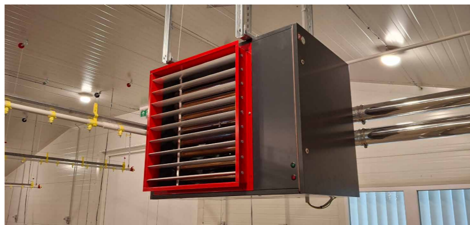
Az épületek klimatizáltak, fűtésük hőlégfűtéssel, hűtésük hűtőpanelekkel komputer vezérelt, és automatizált.
